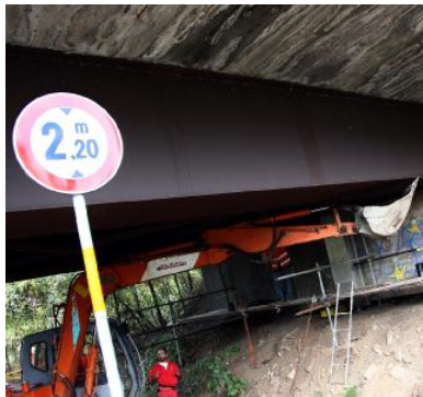
L'intervento tampone sul ponte dopo il cedimento del 2008
