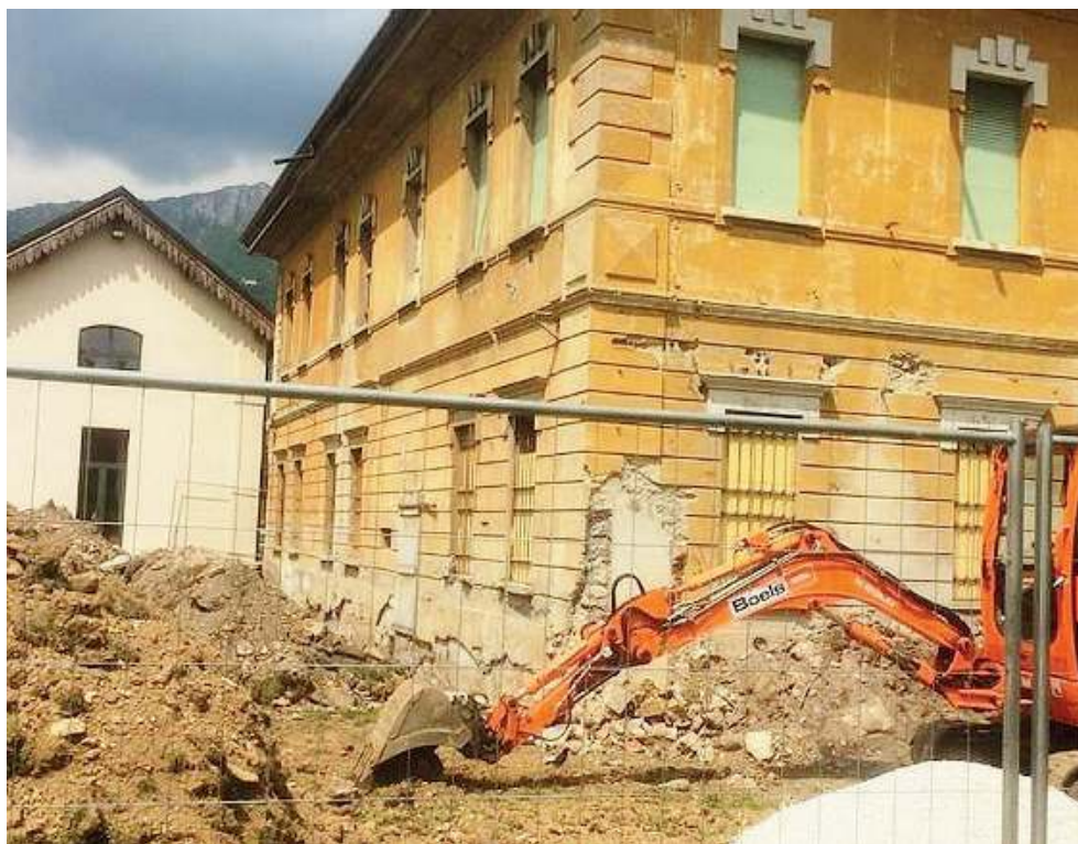
Ruspe in azione. I lavori avviati alla Palazzina liberty nel Parco del Mella a Gardone
