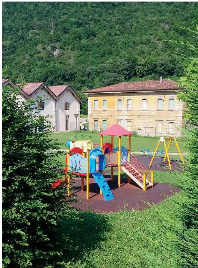
La palazzina. Nell'edificio troverà spazio anche una sala multimediale
