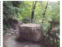
I massi che verranno rimossi
